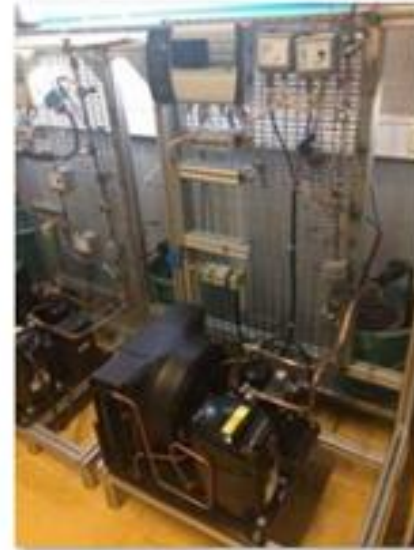
✔ installation frigorifiques pour réalisation d'épreuve de synthèse
