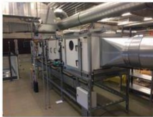
✔ unité HVAC toussaint nyssenne
