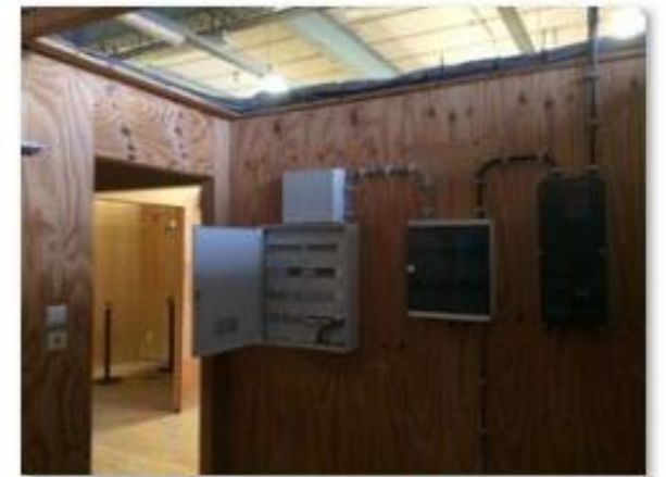
✔ Cablage intérieure de la maison
